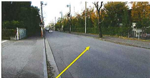
⑫黄色のセンターラインが消えている。
